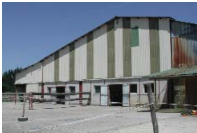
Am Rande des Dorfes liegt die Gestütsanlage mit dem hier abgebildeten Stall. Gleich anschliessend erstrecken sich die weitläufigen Weiden.
